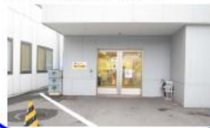
講堂棟入口（防災センター）
