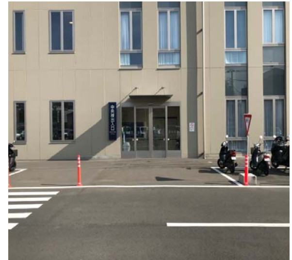
中央棟(入院病棟他出入口)
